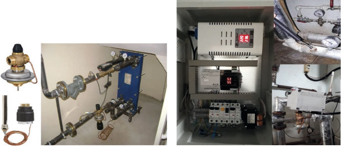
Şekil 26. Bina altı enerjiden bağımsız debi kontrol sistemi [89]
